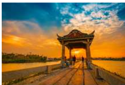
สะพานอันผิง
