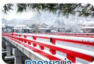
คาคายาบา สะพานนากะบาชิ
